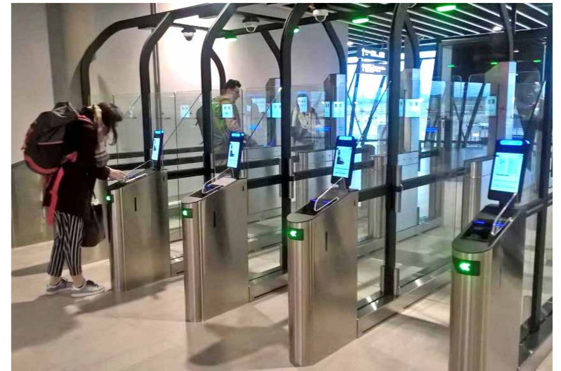
Moderne, automatisierte Grenzkontrolle mit Hilfe von sogenannten E-Gates der Firma Gunnebo am Flughafen von Lyon in Frankreich. (Quelle: Gunnebo)
